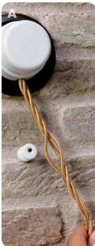
Фиксация с помощью узлов позволяет правильно позиционировать кабель и обеспечить необходимое натяжение. После подключения кабеля в распределительной коробке начните фиксировать кабель на ближайшем к коробке изоляторе в ниже описанном порядке. При этом узлы должны выполняться со стороны коробки.
