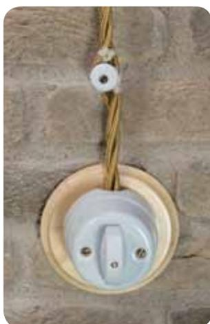
Теперь кабель зафиксирован на фиксаторах и основах. Фиксаторы имеют эксцентрические отверстия, позволяющие осуществлять регулировку в диапазоне  $\pm 1,5$  мм, обеспечивающую выравнивание кабеля при вращении изолятора вокруг его винта. После окончания регулировки затяните винты до конца и монтаж системы будет завершен.
